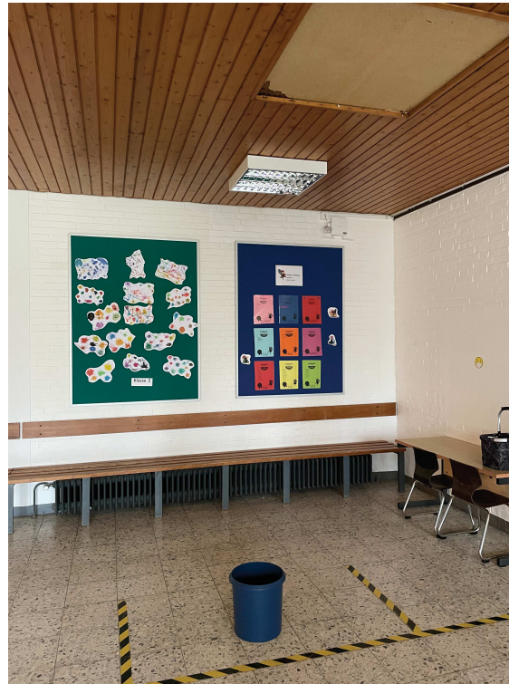
Wasserschäden im kompletten Dach der Aula Abgängige Dachfläche Setzungen im Bereich des Fußbodens
