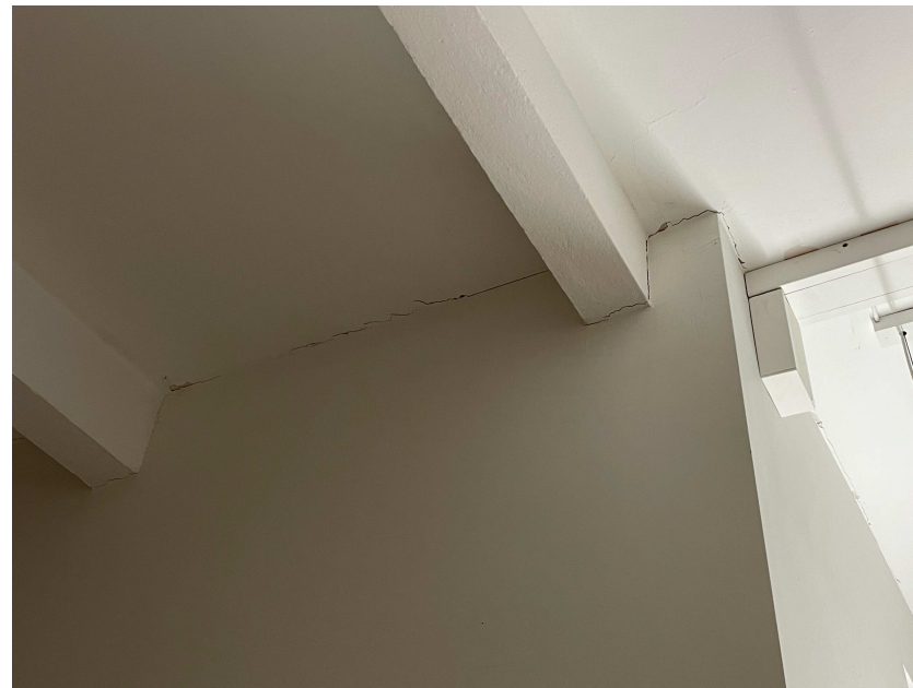
Offene Stahlträger und verkleidete Holzbalkenlage / Brandschutz Aufnahme der Statischen Lasten / Unzureichende Querschnitte
