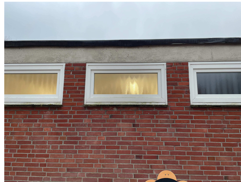
Energetisch Mangelhafte Gebäudehülle Wärmebrücken Anschlüsse Dachabdichtung
