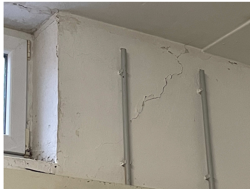
Feuchtigkeitseintrag im Deckenbereich Heizungsraum Rissbildung im Bereich der Außenwände Heizungstechnik abgängig
