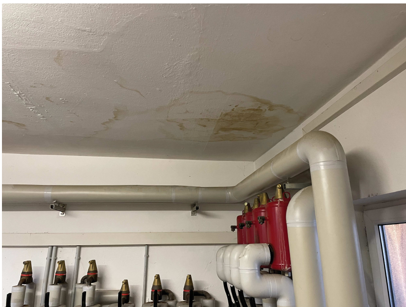
Feuchtigkeitseintrag im Deckenbereich Heizungsraum Rissbildung im Bereich der Außenwände Heizungstechnik abgängig
