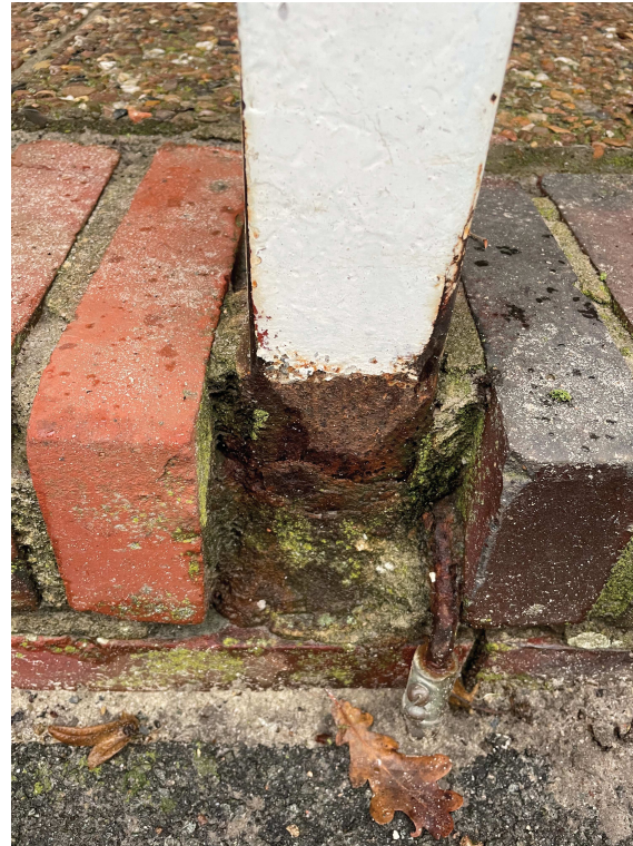
Kein Barrierfreier Zugang Erhebliche Korrosion an der Vordachanlage
