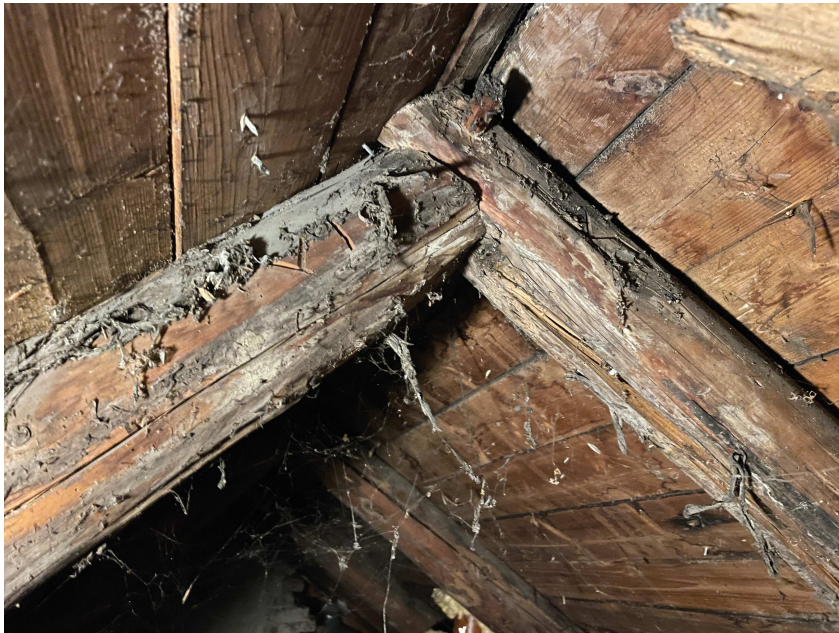
Abgängiger Dachstuhl Feuchtigkeitsschäden Rissbildung auf Grund von Überbelastung der Sparren Energetische Mängel / Dämmung / Schadstoffe
