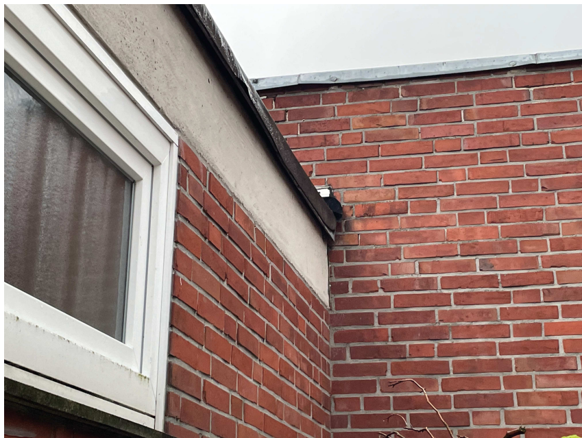
Energetisch Mangelhafte Gebäudehülle Wärmebrücken Anschlüsse Dachabdichtung
