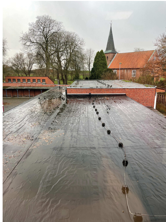
Wasser auf der Dachfläche Kein Verbund der Abdichtung zur Konstruktion Dachflächen abgängig
