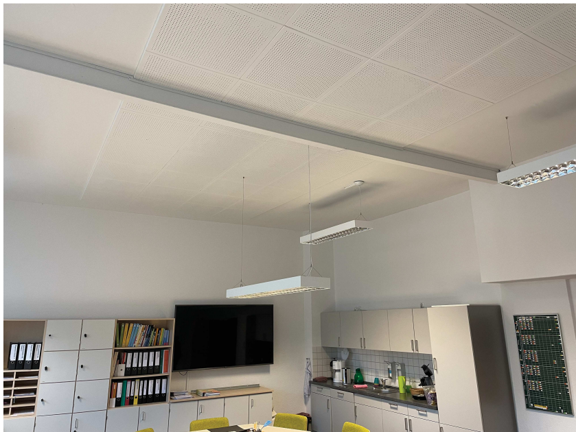
Offene Stahlträger und verkleidete Holzbalkenlage / Brandschutz Aufnahme der Statischen Lasten / Unzureichende Querschnitte
