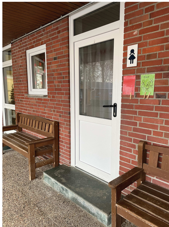
WC Anlagen im Außenbereich Stolperstellen und Stufen Kein Barrierefreier Zugang WC
