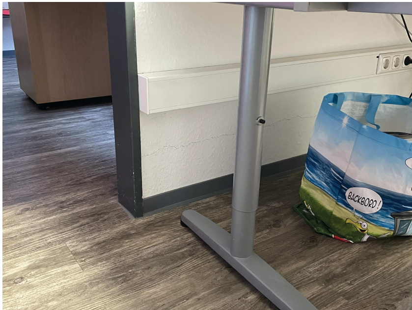
Erhebliche horizontale Rissbildung an Decken und Wände Bereich Verwaltung
