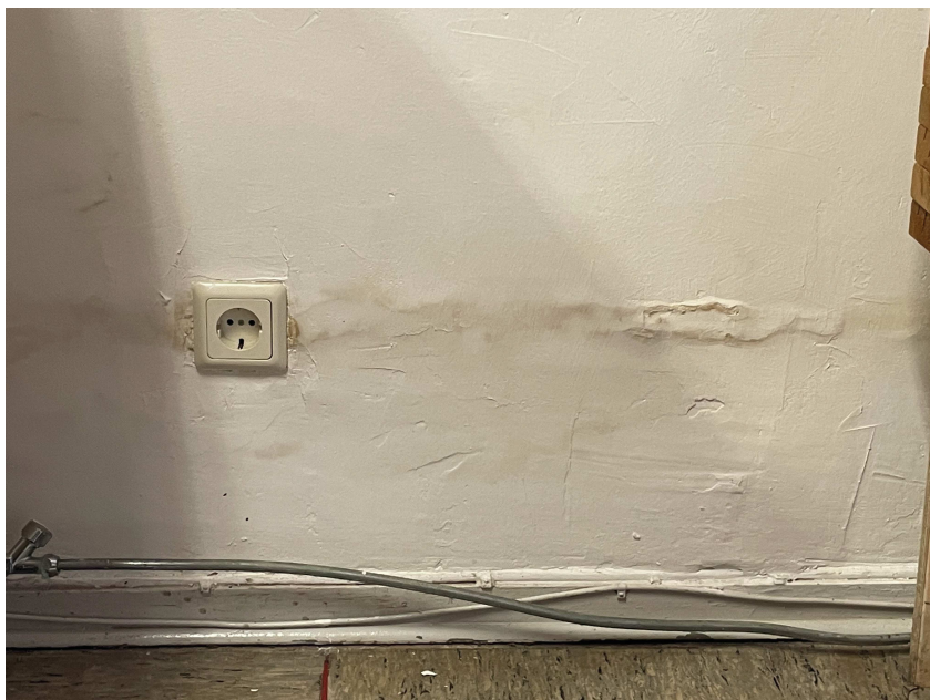
Erhebliche Feuchtigkeitsschäden in den Außenwänden Ausblühungen / Abplatzungen
