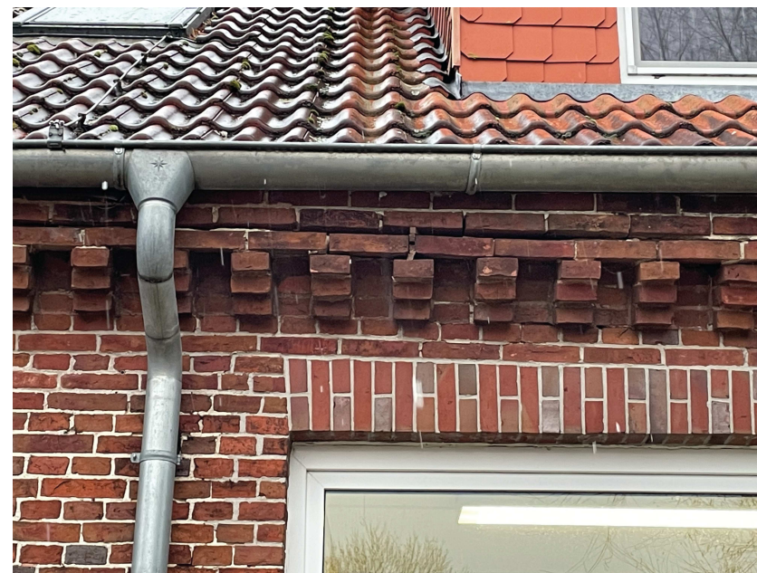
Extreme Beanspruchung der Anker im Mauerwerk Abgängige Außenmauern / Risse
