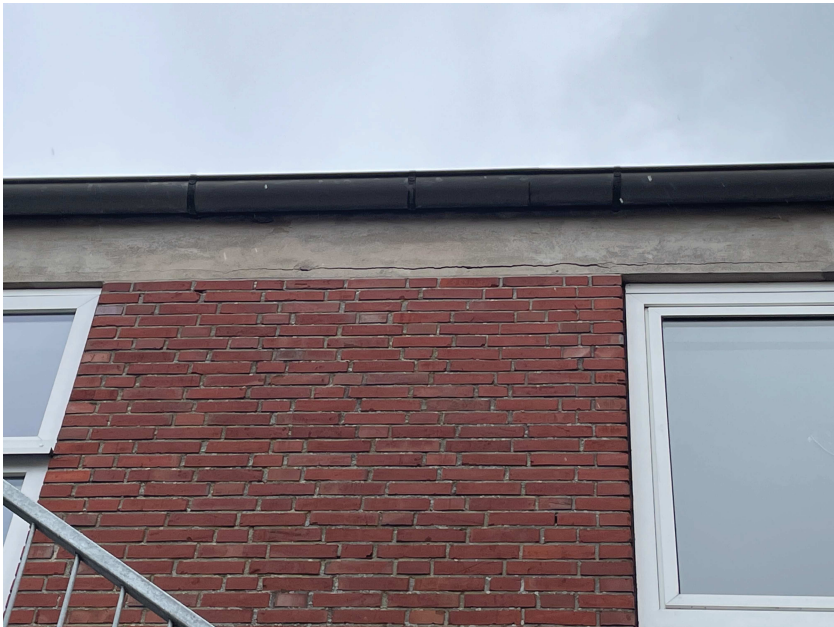
Partielle Ausbesserung am Außenmauerwerk Rissverpressung Instandhaltungsmaßnahmen
