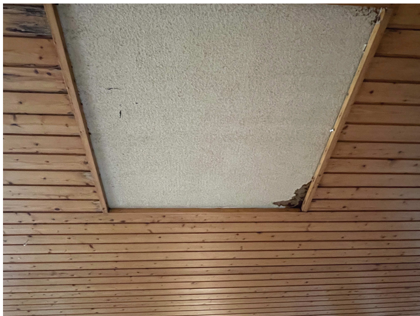
Wasserschäden im kompletten Dach der Aula Abgängige Dachfläche
