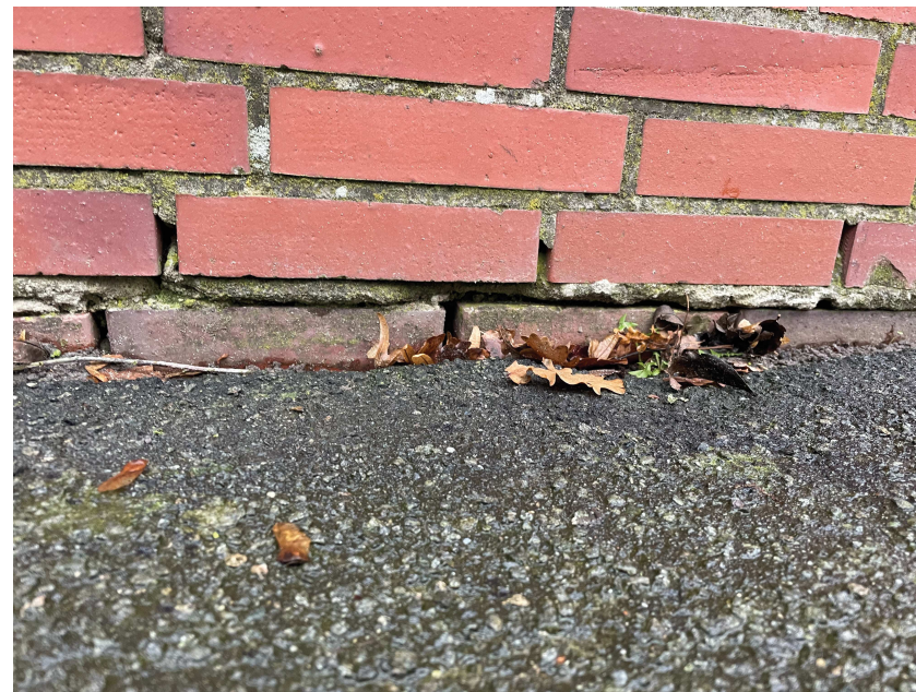
Offene Fugen im Sockelbereich Feuchteintrag in das Mauerwerk
