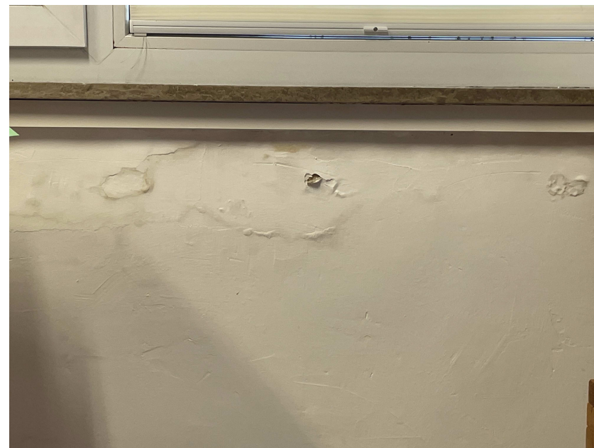
Erhebliche Feuchtigkeitsschäden in den Außenwänden Ausblühungen / Abplatzungen
