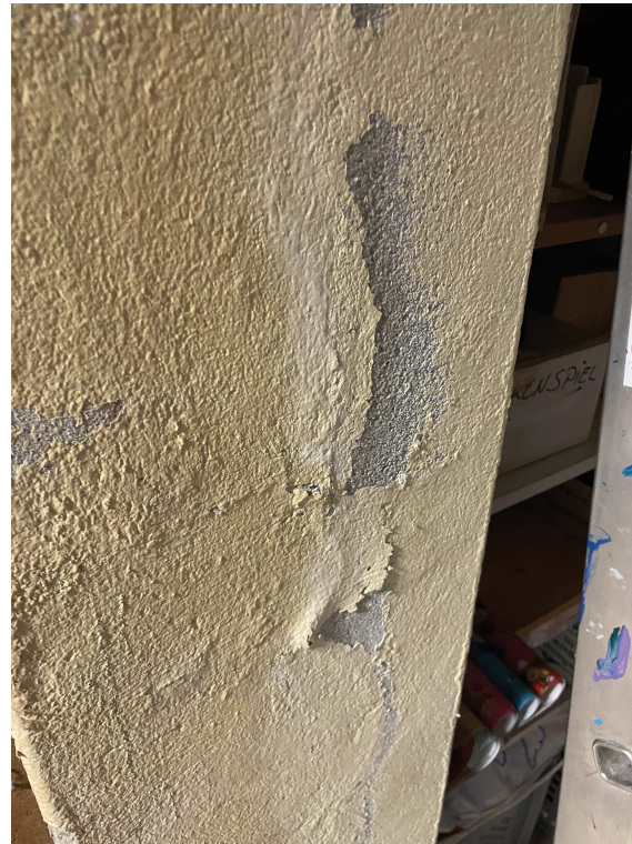
Vertikale durchgehenden Rissbildung (rot) Feuchtigkeitseintrag und Ausblühungen im Mauerwerk
