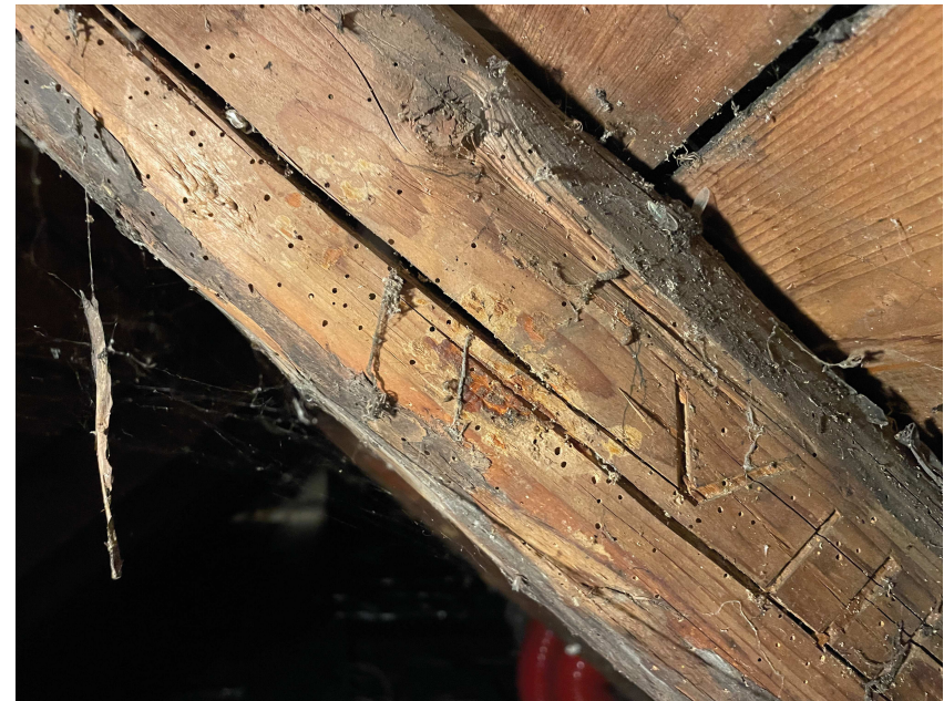
Abgängiger Dachstuhl Holzwurmbefall Rissbildung auf Grund von Überbelastung der Sparren Energetische Mängel / Dämmung / Schadstoffe
