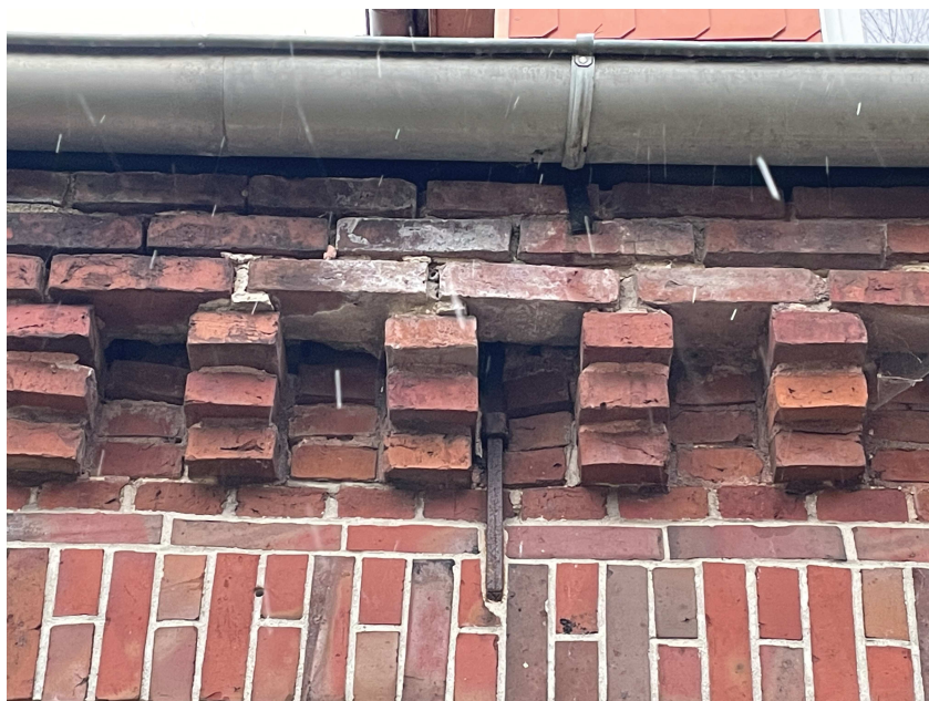
Extreme Beanspruchung der Anker im Mauerwerk Abgängige Außenmauern / Risse
