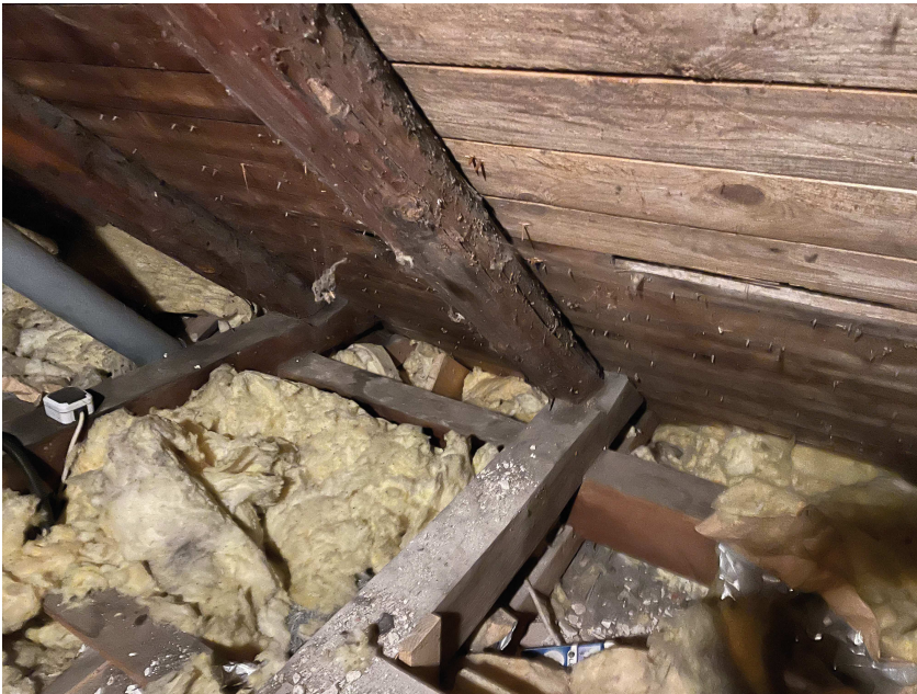
Abgängiger Dachstuhl Holzwurmbefall Rissbildung auf Grund von Überbelastung der Sparren Energetische Mängel / Dämmung / Schadstoffe
