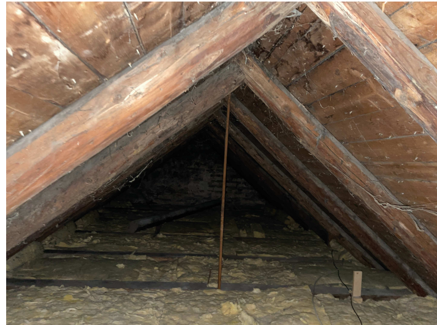
Abgängiger Dachstuhl Feuchtigkeitsschäden Rissbildung auf Grund von Überbelastung der Sparren Energetische Mängel / Dämmung / Schadstoffe
