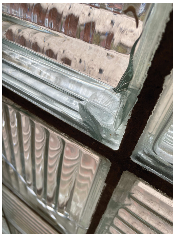
Defekte und Ausgebrochene Glasbausteine im Treppenhaus Gefährliche Schnittkanten
