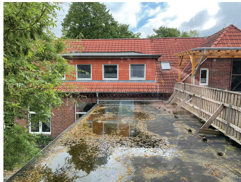
Wasserschäden im kompletten Dach der Aula Abgängige Dachfläche
