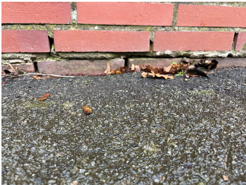
Offene Fugen im Sockelbereich Feuchteintrag in das Mauerwerk
