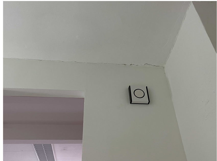
Erhebliche horizontale Rissbildung an Decken und Wände Bereich Verwaltung
