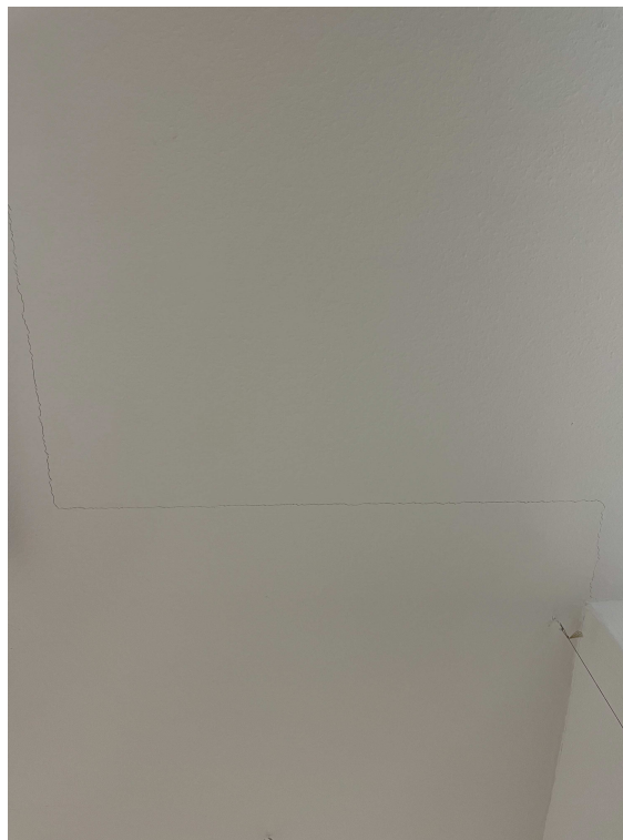
Bereich Kindergarten Höhenunterschied GS / Kita Erhebliche Rissbildung der Decken
